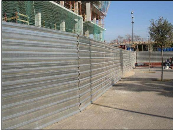
Figura 11 Vallas metálicas para construcción
